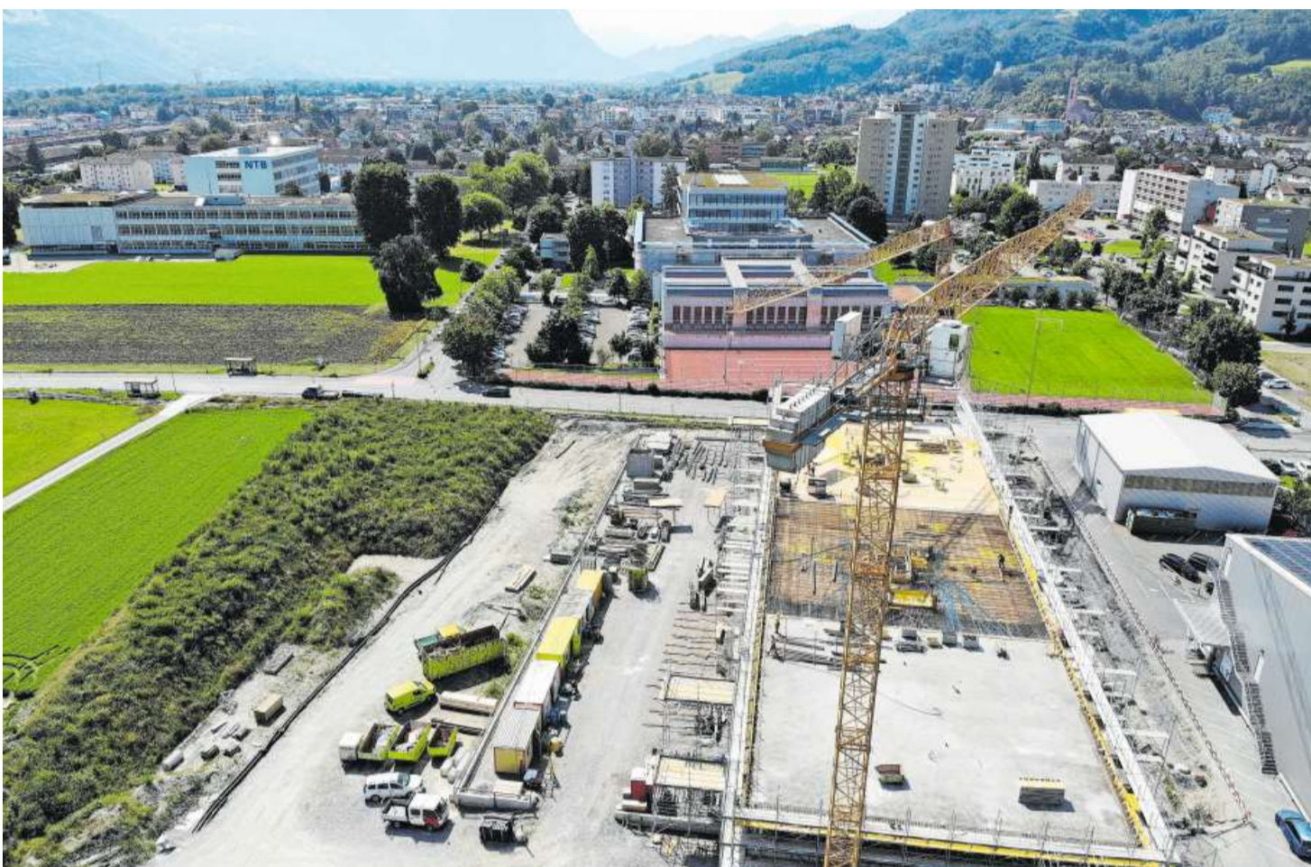
Nördlich des BZB und der NTB befindet sich das Industriegebäude im Bau, in das die Brusa Elektronik AG einziehen wird. Bild: Michael Kyburz
