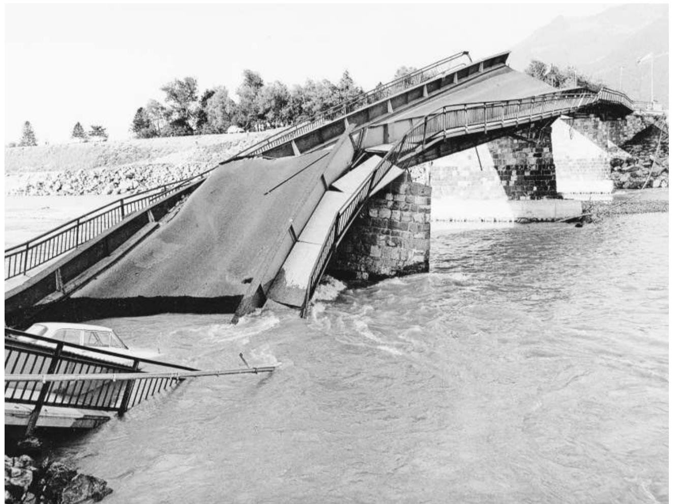
Dieses Foto entstand kurz nach dem Einsturz der Brücke und zeigt das Auto von Unternehmer Paul Klaus aus Buchs, das ins Wasser rutschte. Bild: Archiv Hansruedi Rohrer
